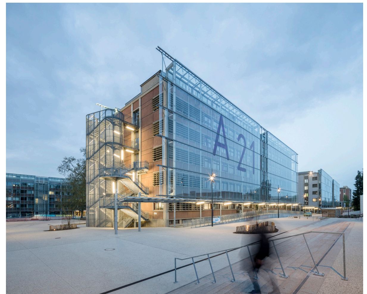
Façade bioclimatique du bâtiment A21
