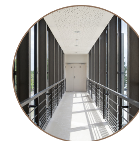
Passerelle entre A1 et A2 vue intérieure
